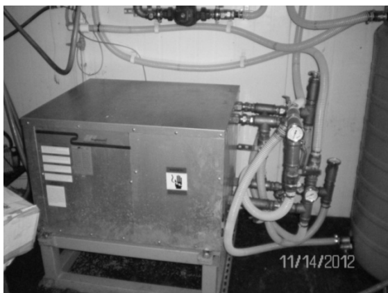
Рис.2. Моноблочный тепловой насос
