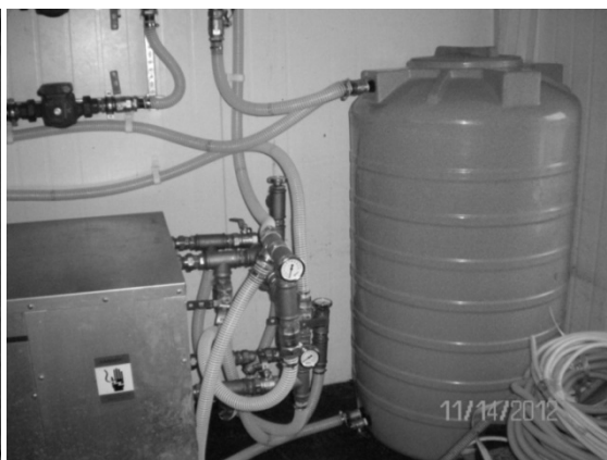
Рис.3. Часть водяного контура и бак-аккумулятор
