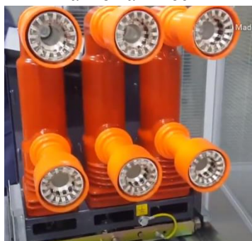
Высоковольтный автоматический выключатель
