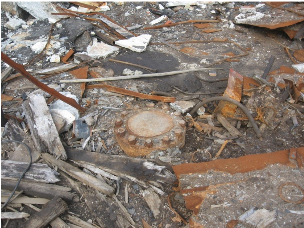
Рисунок 2 – Заваренное отверстие ствола скважины СГ-3
