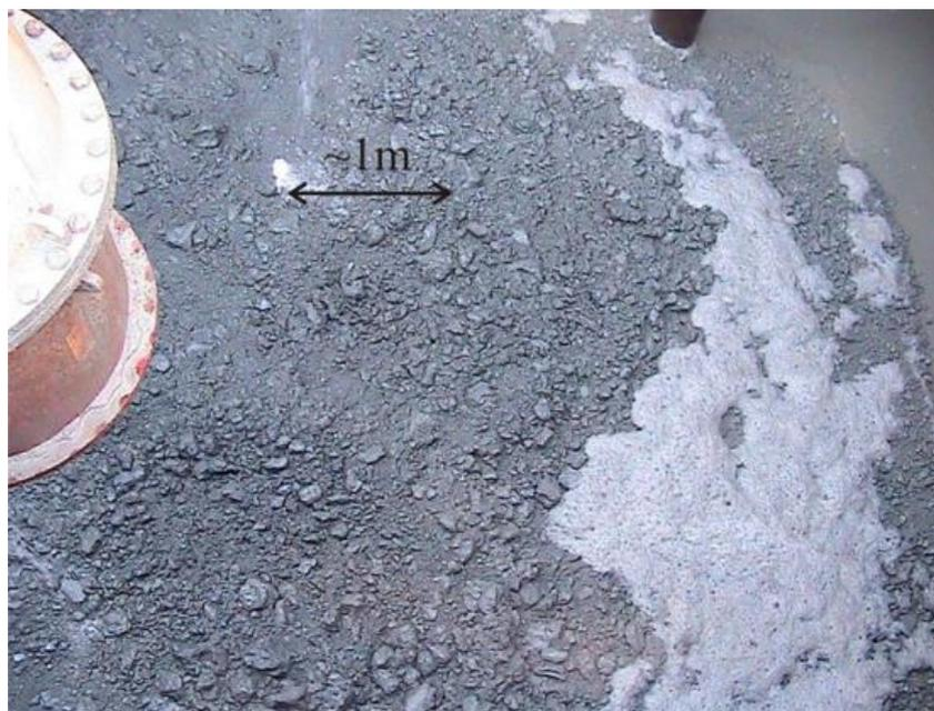
Рисунок 2 – Срезки суглинистых грунтов твердой-тугопластичной консистенции в бункерном трюме
