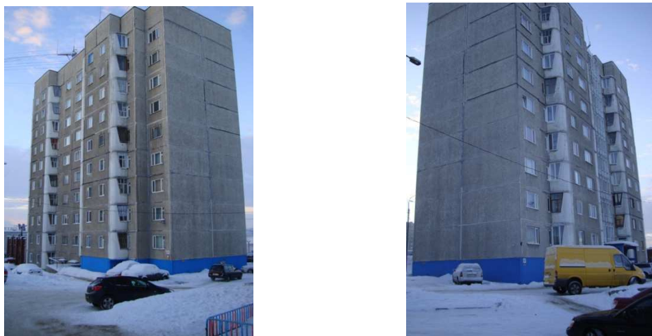
Рисунок 1 – Жилое многоквартирное здание, расположенное по адресу: г. Мурманск, ул. Старостина, д. 57.
