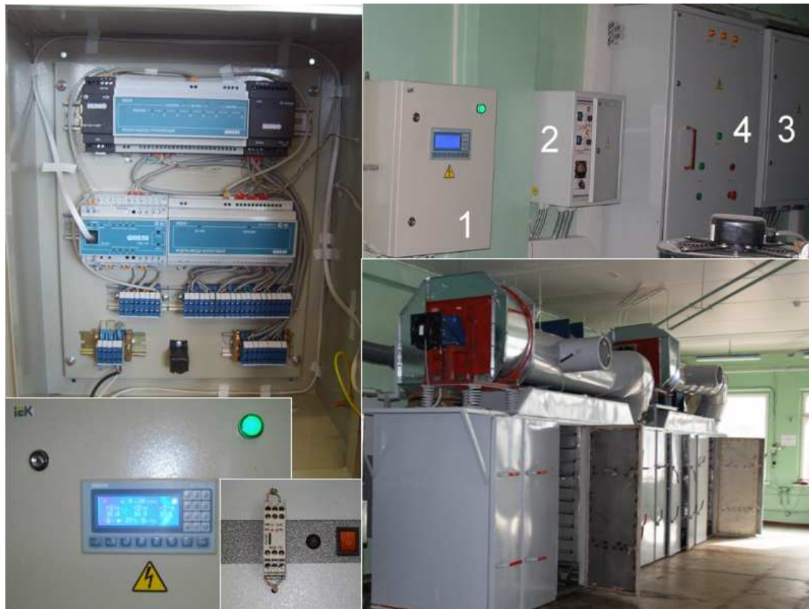
Рисунок 2 – Система автоматического управления УКСУ
